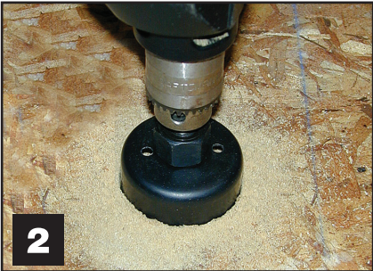
Figure 2 - Drill hole in floor using a hole saw. Figure 2 - Percer le trou dans le plancher à l'aide de la scie-cloche.
