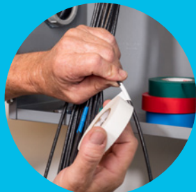
Identification des câbles
