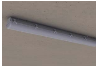
2. Installez le luminaire sur les agrafes.
