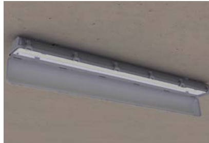
7. Remplacez le plateau dans le luminaire.
